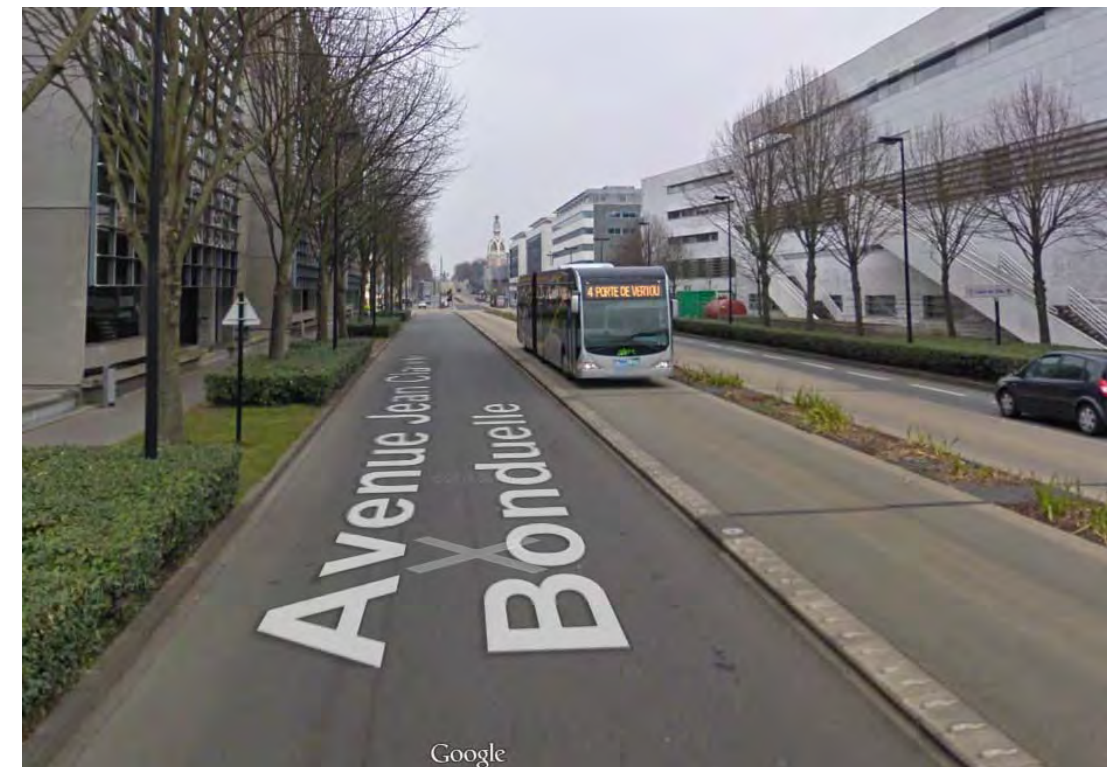
Figure 39 : Insertion axiale en site restreint semi-franchissable Busway de Nantes - Ligne 4 2
