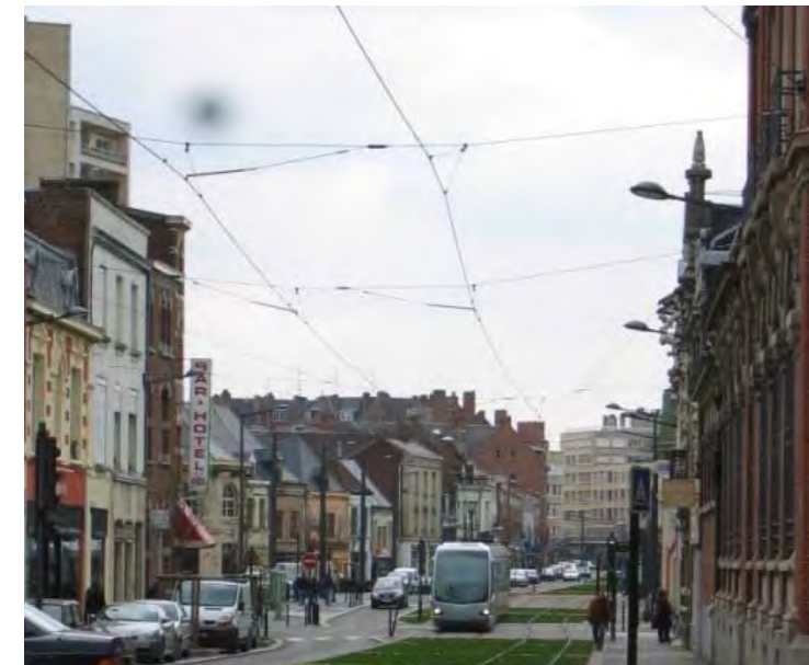
Figure 20 : Exemple ancrages en façade latéraux avec suspension sous transversal (Tramway de Valenciennes)
